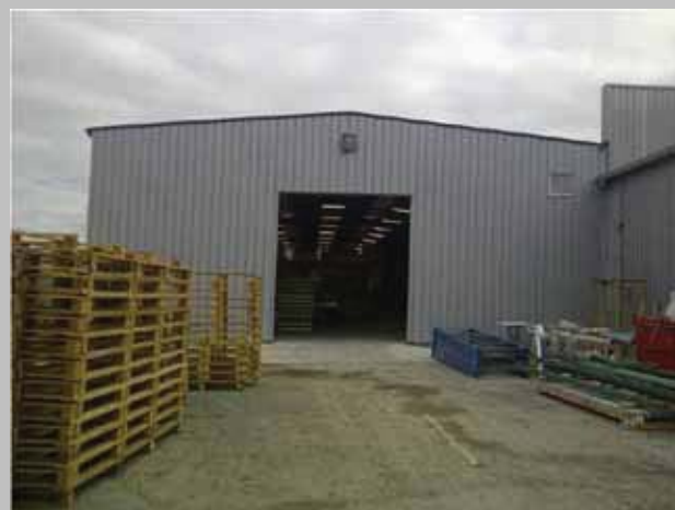
Extension des ateliers de 1 000m 2 réalisée en 2011
